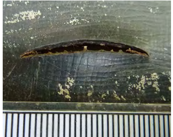
Abbildung 10: Objekt D) Detailaufnahme von Schädigungen der Dachbahn in der Fläche.
