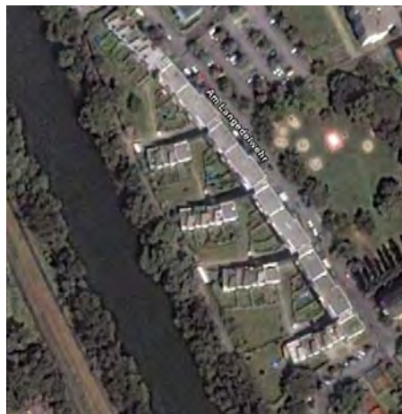
Abbildung 5: D) Wohnungseigentümeranlage mit ca. 4.500 m 2 Dachfläche
